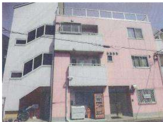
（しなのめハウス本館 玄関前）
